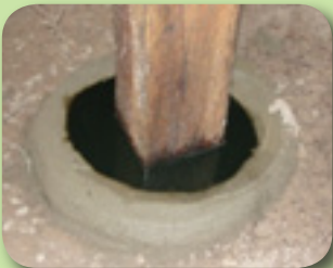
Proteção contra formiga: óleo ao redor do pé do suporte
